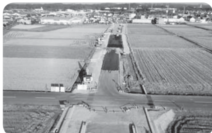
都市計画道路 諸井山の手線改築工事
